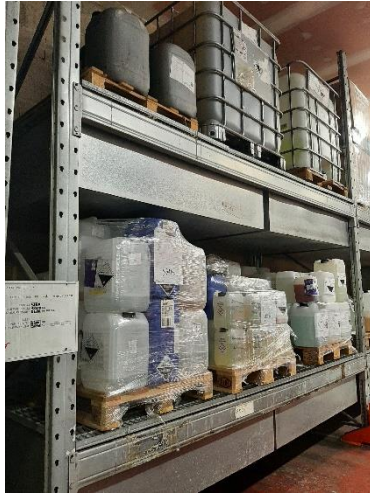
Stockage des déchets basiques, sur rétention
